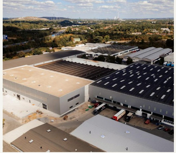
Gelsenkirchen üretim tesisi. Resmî gym80 fotoğrafı.
